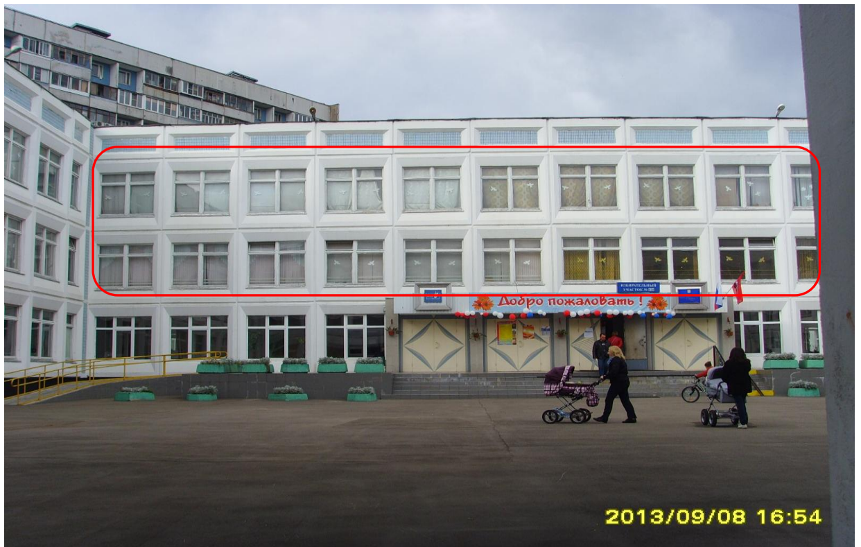
Фото 8-14. Школа №1099. Светопроемы зачем то закрыты шторами. Входные двери вставили без остекления.
