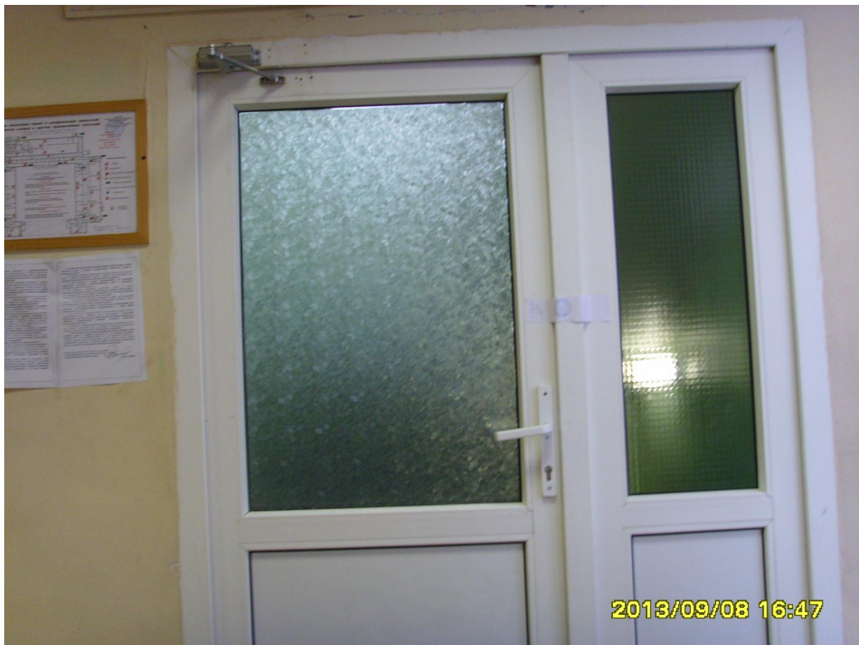
Фото 8-22. Школа №1099. На двери на лестницу, зачем то наклеили матовую плёнку.
