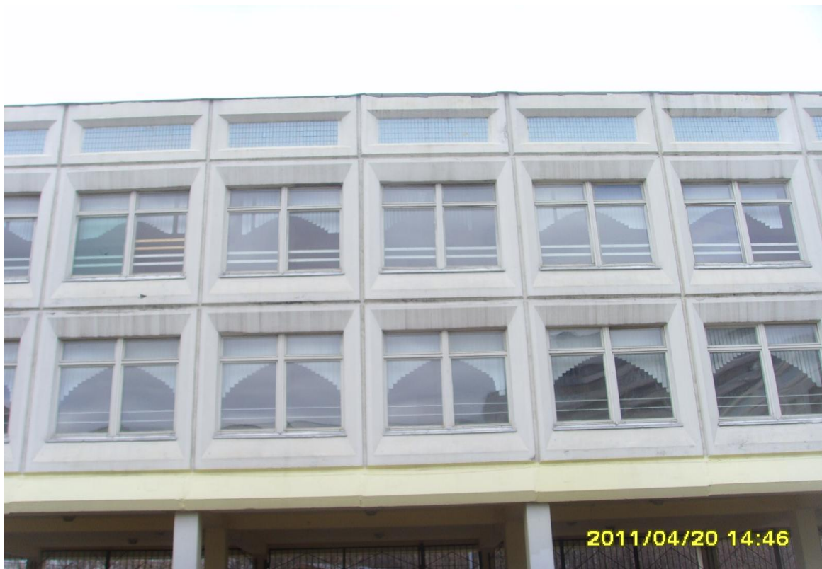
Фото №3. Школа 1099 (Юг). Светопроемы в классах постоянно завешены тряпьем. Алюминиевые двери со светопроемами поменяли на стальные без светопроемов. На первом этаже немного раздвинули тряпье.
