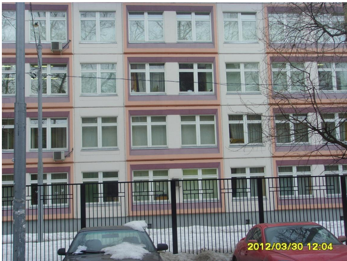
Фото №19. Школа 1137 (Восток). Большинство светопроемов постоянно завешены тряпьем. Зачем то установили в классы кондиционеры.
