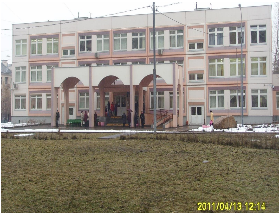
Фото №18. Школа 1137 (Юг). Светопроёмы постоянно завешены тряпьем.
