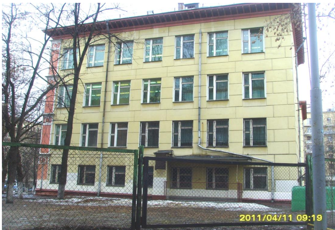
Фото №23. Школа 1226 (Восток). Светопроёмы завешены тюлем. Часть деревьев спилили.
