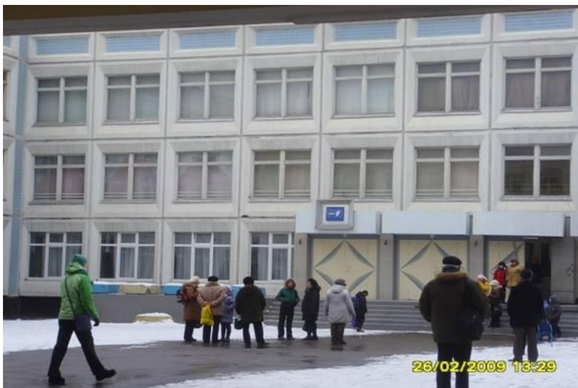
Фото №2. Школа 1099. Светопроёмы в классы и рекреации (1 этаж) постоянно завешены. Алюминиевые двери со светопроёмами поменяли на стальные без светопроёмов.
