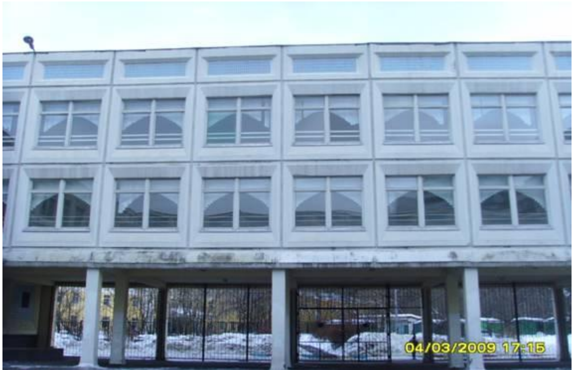
Фото №3. Школа 1099. Светопроемы в рекреации, где учатся младшие классы постоянно завешены дурацкими ламбрекенами. Свет, который должен был достаться детям отражается на улице.
