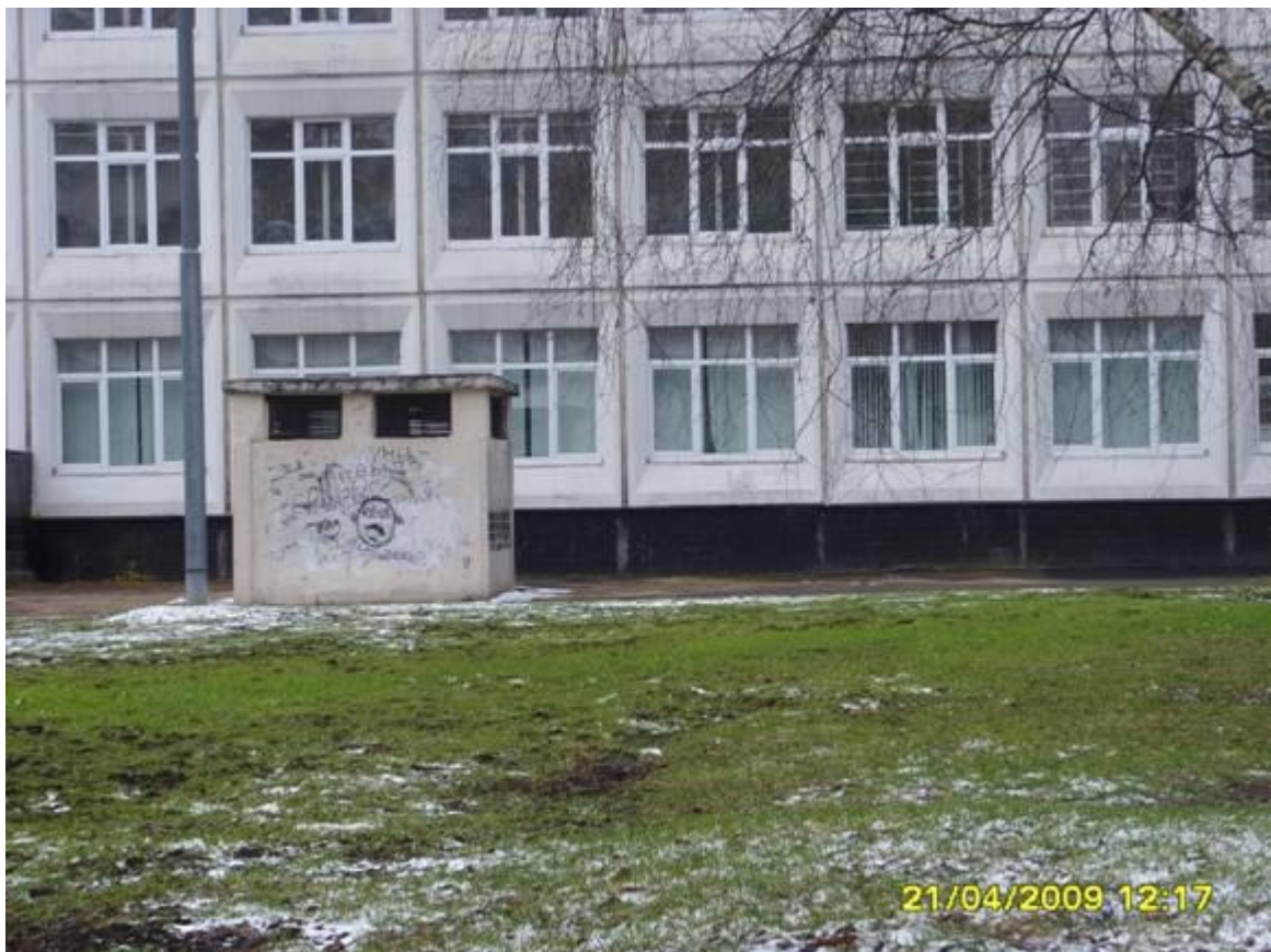
Фото №5. Школа 1099. Светопроёмы в столовую постоянно перекрыты при помощи жалюзи.
